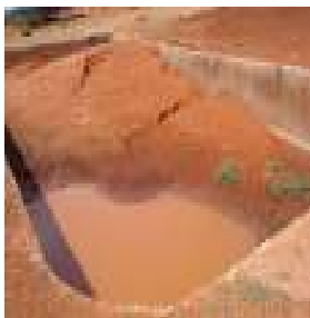
Siltation of ponds
